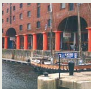
Einheitliche Fassade, Unterbringung diverser Nutzungen
